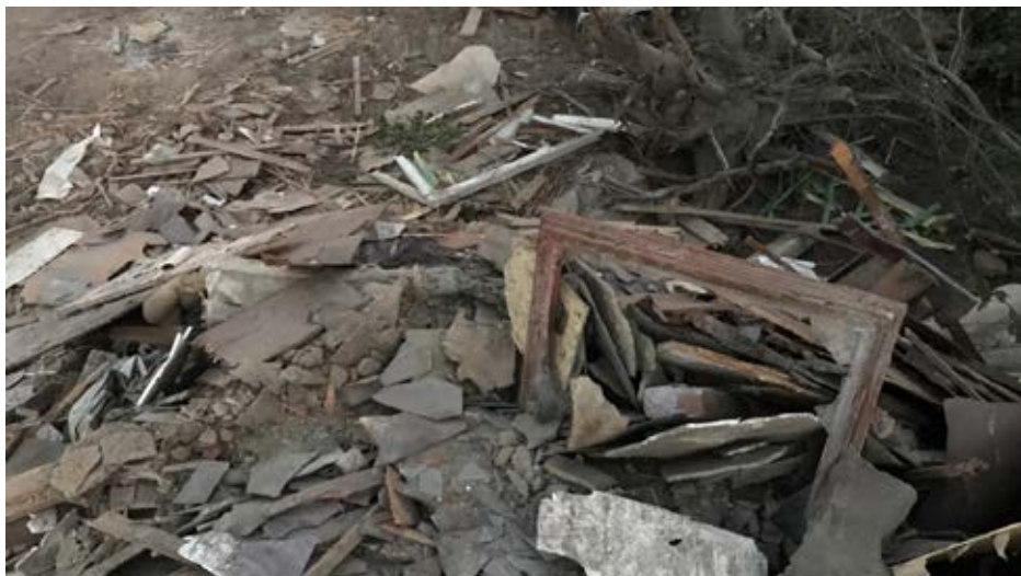
Unsachgemäßer Umgang mit Asbestfaserzementbaustoffen
