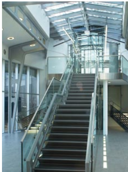
Funktioniert im Betrieb die Zutrittskontrolle auch bei Stromausfall ?
